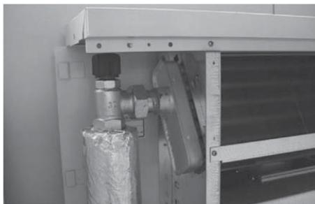
散热疏水阀 / 散热阀 ID- 图表
